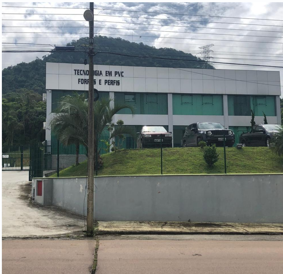
FACHADA DA SEDE DAS RECUPERANDAS – RIO DO SUL - RS
