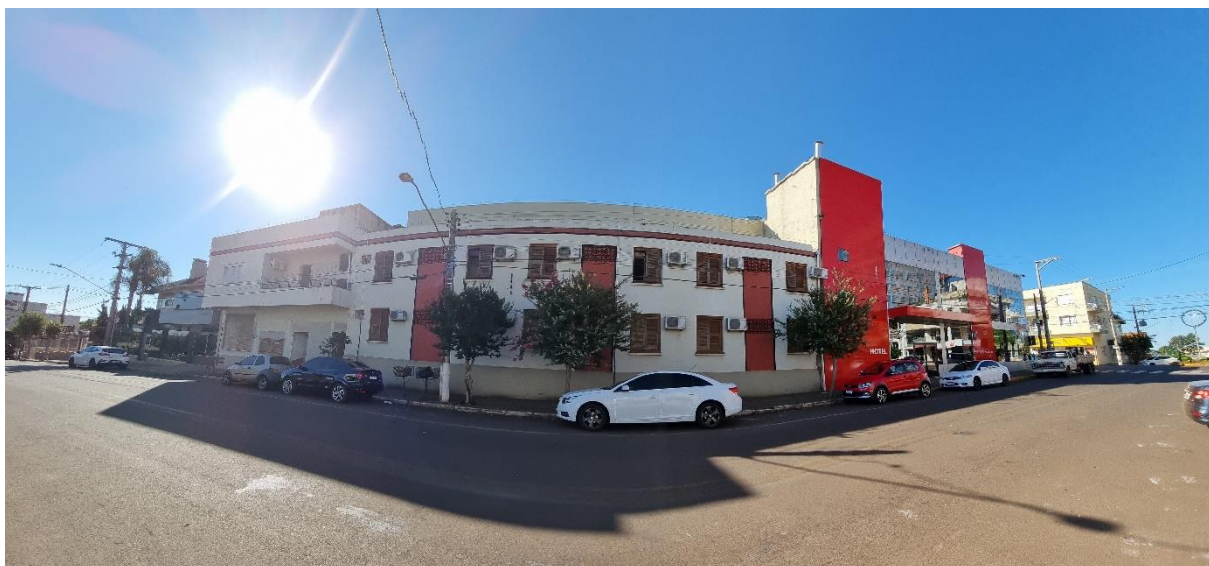
Vista da fachada na rua Valentim Rumpel
