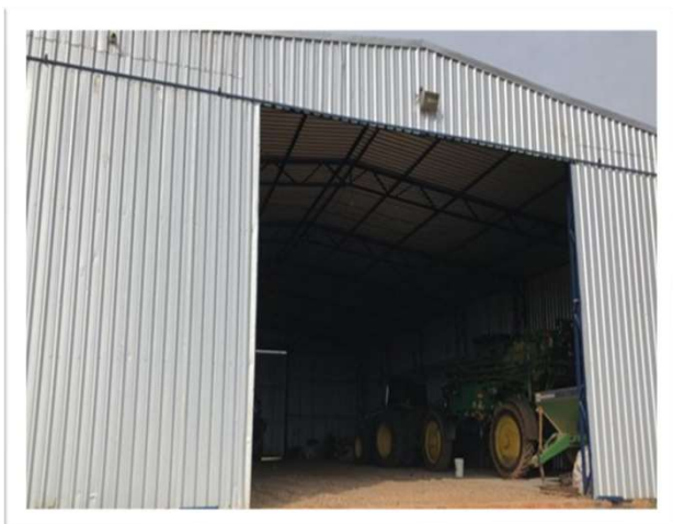
Galpão de Armazenagem
