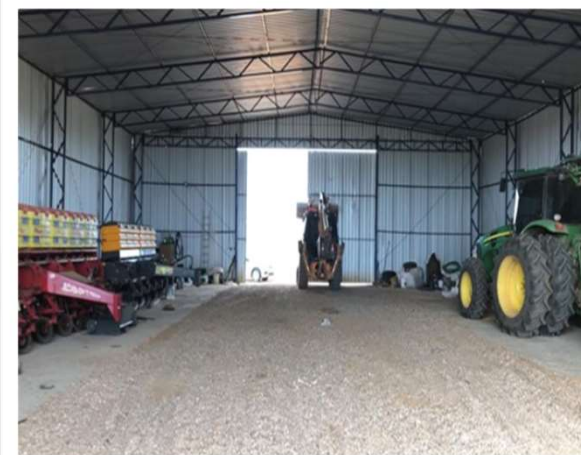
Galpão de Armazenagem
