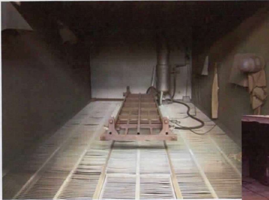
Jato de Granalha
