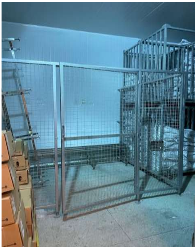
Câmara frigorífica reformada
