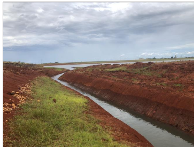
Canal de irrigação da barragem
