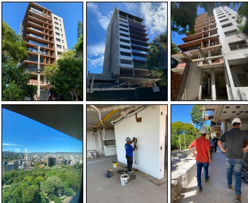
Registros do empreendimento La Pierre realizados por esta Equipe no dia 14 de março de 2023.
