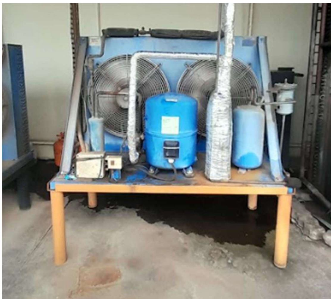
28 – HGM160 UNIDADE CONDENSADORA DANFOS
